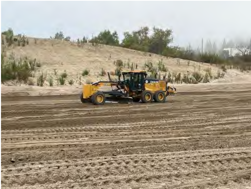
Grading_compiling_sediment_faceW.jpg -118.17146381944445 34.19302983333333
