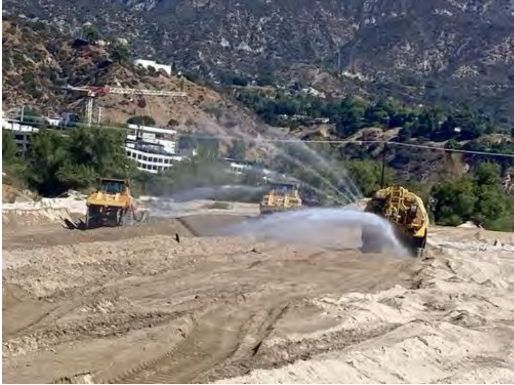
Grading_moving_sediment_FacingN.jpg
