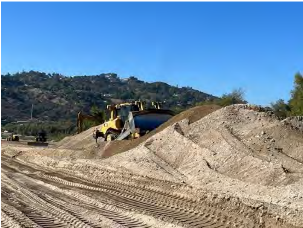
Bulldozer_creating_dirt_mound_for_removal_faceSW.jpg
