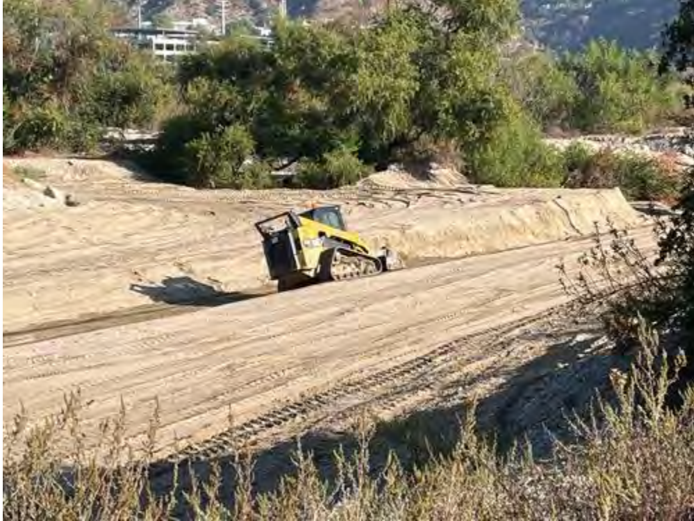
Skid_steer_grading_faceNW.jpg -118.17071959444445 34.19407168055555
