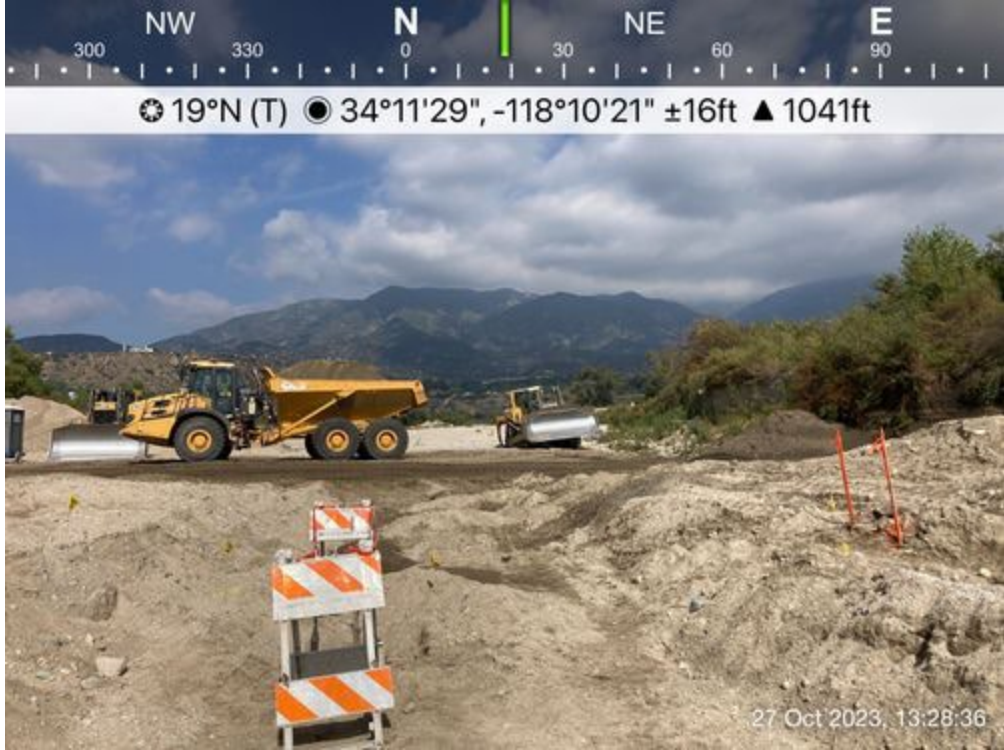
Compaction_of_soils.JPG -118.17259722222222 34.19158055555554
