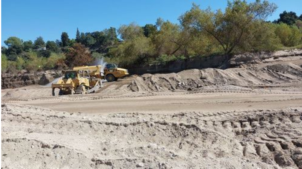
watertruck_wetting_bank_reconstruction_facingEast.jpg -118.17303391666667 34.19125027777776
