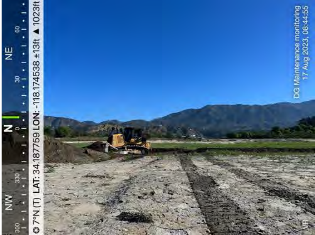
Bulldozer_Scraping_Sediment_facingNorth_081723.JPG -118.1745388888889 34.1877583333333
